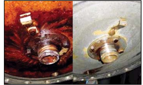
Крышка баллона загрязненный
